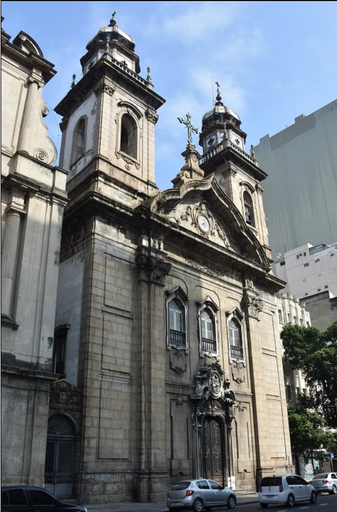
Vista da fachada principal da Igreja da Ordem Terceira de Nossa Senhora do Monte do Carmo e detalhes. Foto: (30-abril-2024)
