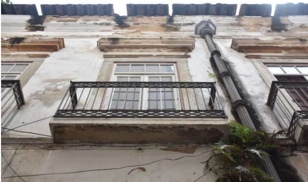
Detalhe da fachada lateral direita. Observar a degradação avançada da cimalha, dos elementos ornamentais sobre as portas e do beiral com a ausência de muitas telhas, Presença de vegetação daninha, crosta negra e infiltração descendente acentuada. Foto: (-03/24)
