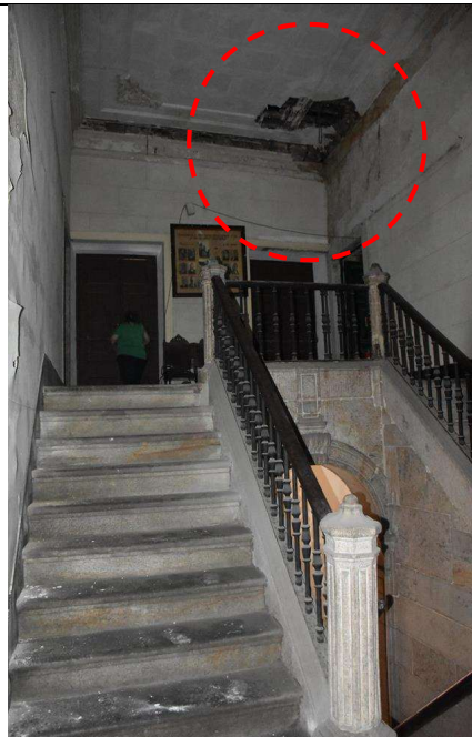
Escada de acesso ao pavimento superior onde podemos observar o encharcamento dos degraus e das paredes, pela agua da chuva, que provocam uma sequência de degradações das estruturas a partir do telhado, no forro em estuque e nas alvenarias da caixa da escada. Foto: (-03/24)
