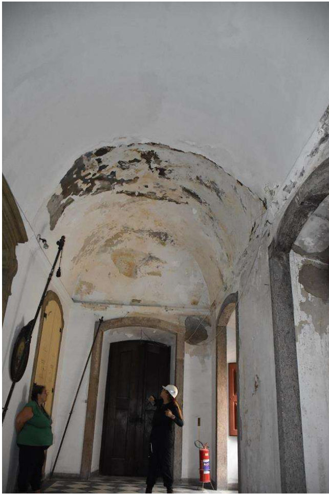
Corredor de acesso às tribunas no pavimento superior onde os efeitos deletérios da infiltração descendente, são claramente detectados no dorso da abóboda. Manchas de humidade, desenvolvimento de microflora, degradação das argamassas. Fotos: (-03/24)
